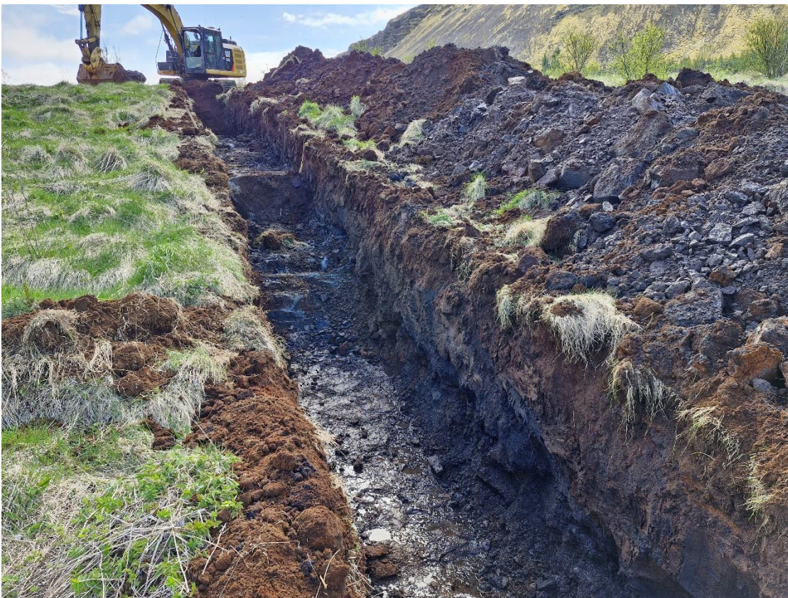
MYND B.18 Könnunarskurður K2, horft til austurs.
