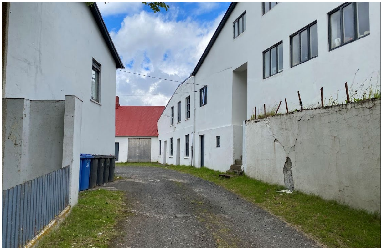
Mynd 31. Blickastaðir sumarið 2022. Þegar mjólkurhúsið var byggt árið 1958, var gamla timburhúsið sem var á staðnum rífið. Í dag sér móta fyrir grunni þess í heimreiðinni. 82
