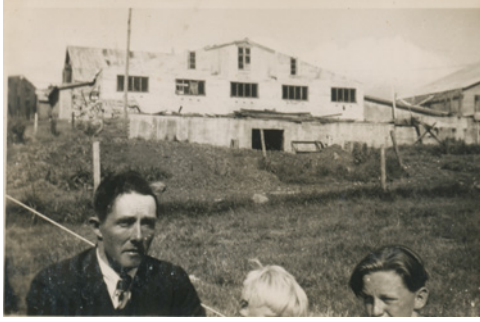
Fjósið og haughúsið í byggingu ca. 1930.
