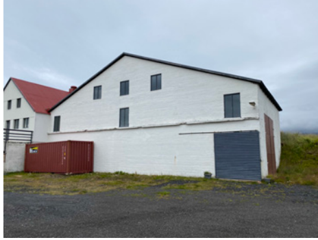
Suðurhlíð hlöðunnar árið 2022.
